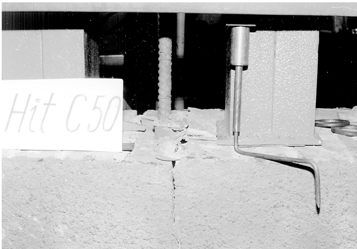
Rys. 11. Zniszczenie układu wklejonego kompozycją H – HIT C50
