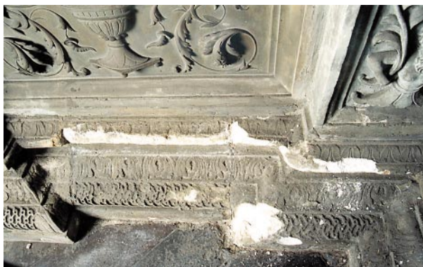
Zniszczony fragment cokołu. Widoczne późniejsze uzupełnienia gipsowe
