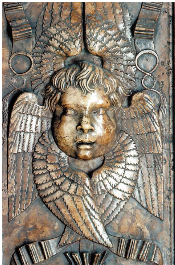
Fragment dekoracji marmurowej. Silne zabrudzenie powierzchni
