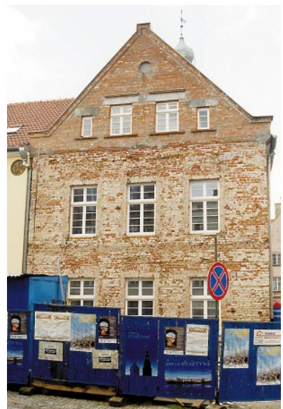
Okna na elewacji zachodniej przed i po zakończeniu prac
