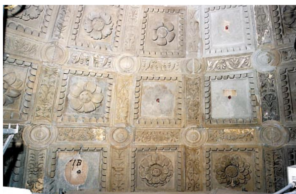
Fragment dekoracji kasetonowej kopuły po zdemontowaniu późniejszych rozet drewnianych
