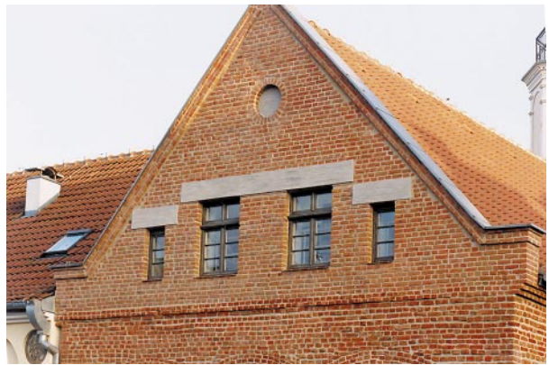
Szczyt elewacji zachodniej po konserwacji
