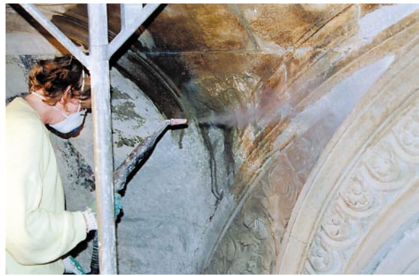
Doczyszczanie powierzchni kamienia parą wodną
