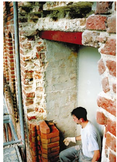
Rekonstrukcja fragmentów profili obramień
