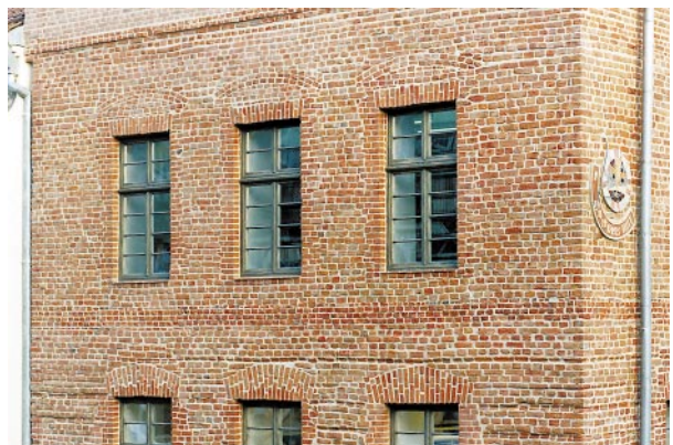
Okna na elewacji zachodniej przed i po zakończeniu prac
