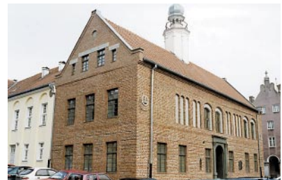
Stary Ratusz w Olsztynie. Strona południowo-zachodnia. Stan po konserwacji
