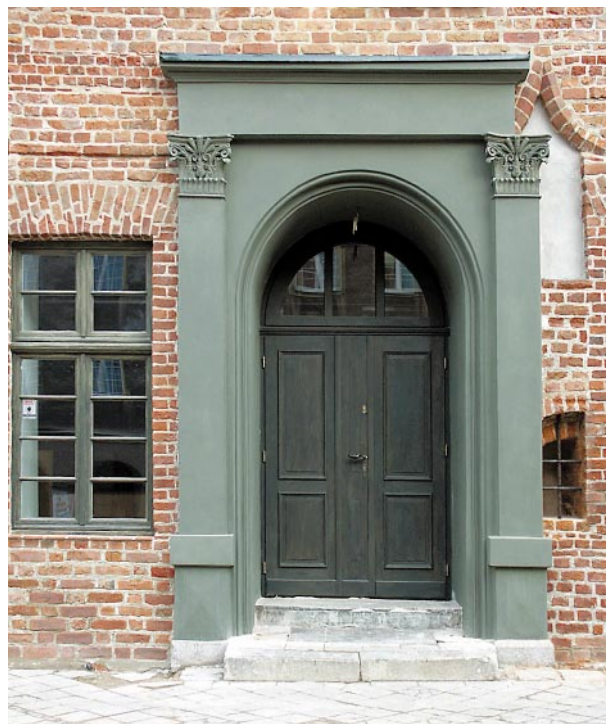
Olsztyn, Stary Ratusz, widok na elewację południową, portal klasycystyczny, widoczna zachowana ostrołukowa blenda i otwór okienny do dawnej hali. Stan po zakończeniu prac konserwatorskich prowadzonych przez firmę Konserwatorską Piotr Biało, Zabytki Malarstwa, Rzeźby Architektury Spółka z o.o. Kraków. Stan z 15 listopada 2003 r. Fot. K. Sobaczewski
