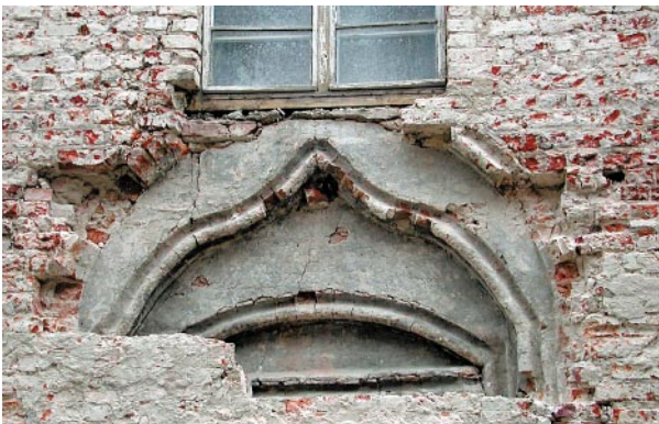
Olsztyn, Stary Ratusz, elewacja wschodnia, po usunięciu zamurowania ukazało się zwiercienie portalu z cegły kształtki w „ośli grzbiet”. Stan z sierpnia 2002 r. Fot. K. Sobaczewski
