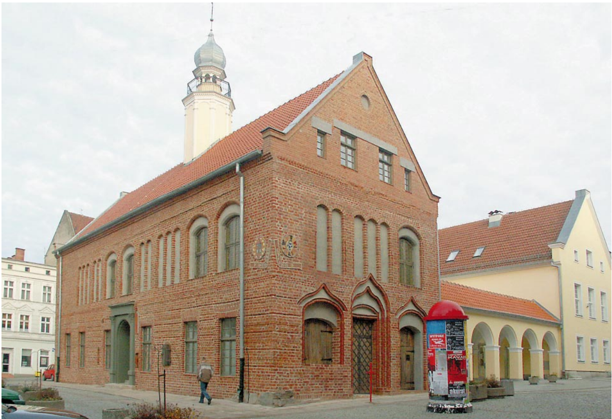
Olsztyn, Stary Ratusz, widok na elewację południowo-wschodnią po zakończeniu prac konserwatorskich prowadzonych przez firmę Konserwatorską Piotr Biało, Zabytki Malarstwa, Rzeźby Architektury Spółka z o.o. Kraków. Stan z 15 listopada 2003 r. Fot. K. Sobaczewski
