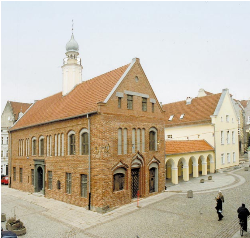
Konserwacja elewacji Starego Ratusza w Olsztynie wraz z przywróceniem walerów gotyckiej budowli
