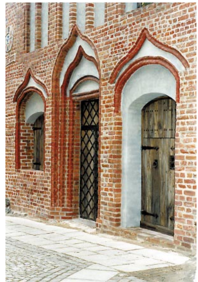
Parter elewacji wschodniej Ratusza po konserwacji
