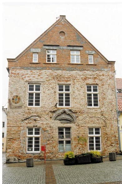
Elewacja wschodnia Ratusza przed konserwacją
