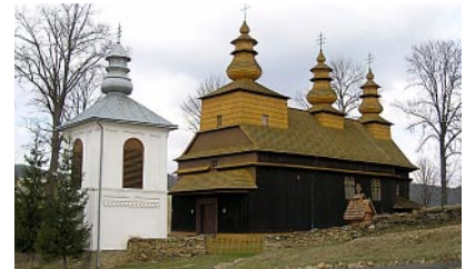
Wisłok Wielki – widok zespołu cerkiewnego po kompleksowych pracach konserwatorskich
