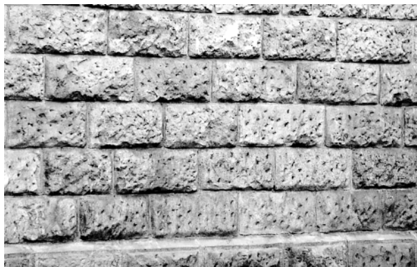
Rustykalny mur oporowy po reprofilizacji (Fot. I. Płuska)
