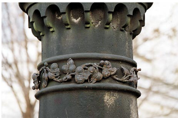
Fragment kamiennego obelisku. Zniszczone metalowe aplikacje wici roślinnych (Fot. M. Majewski)
