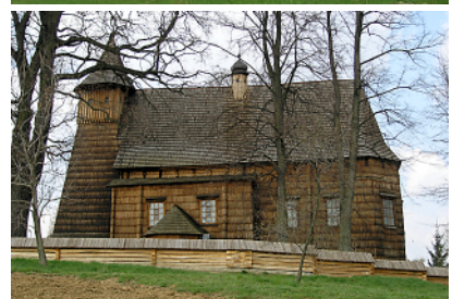
Trzcinica – widok kościoła po pracach konserwatorskich
