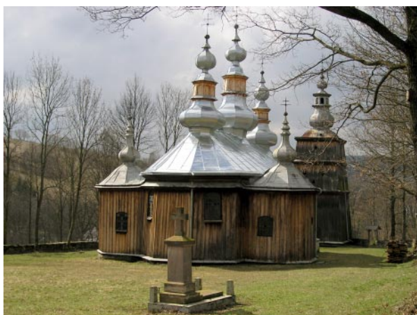
Turzańsk – widok ogólny cerkwi po pracach konserwatorskich
