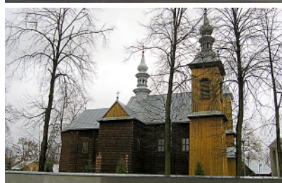
Jaćmierz – widok kościoła po pracach konserwatorskich
