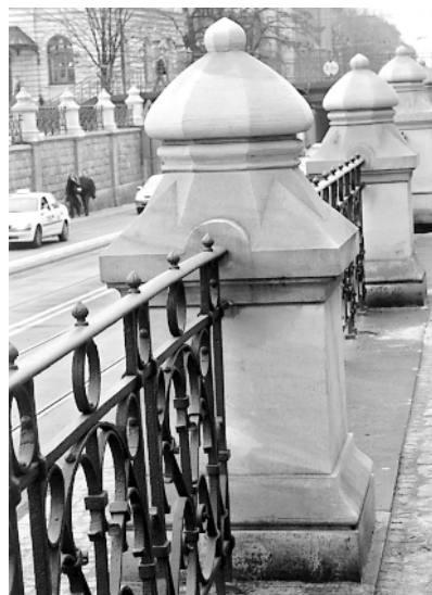
Zrekonstruowane słupki kamienne z odnowioną metalową balustradą (Fot. I. Płuska)
