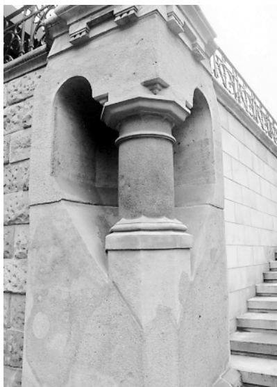
Narożna kolumnka murów oporowych po konserwacji (Fot. I. Płuska)
