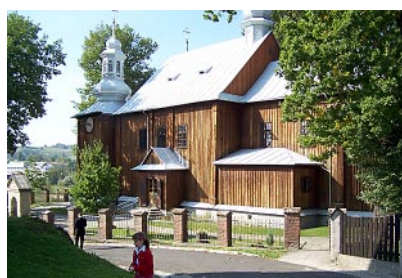
Jasienica Rosielna – widok kościoła po pracach konserwatorskich
