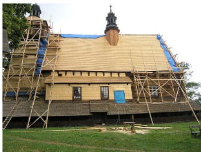
Haczów – kościół w trakcie prac konserwatorskich
