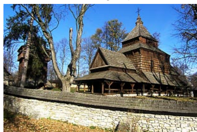
Raduż – widok zespołu cerkiewnego po pracach konserwatorskich
