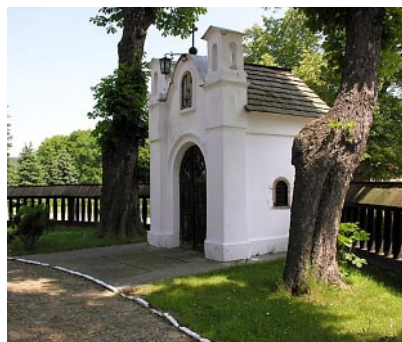
Blizne – kaplica w obwodzie ogrodzenia placu kościelnego
