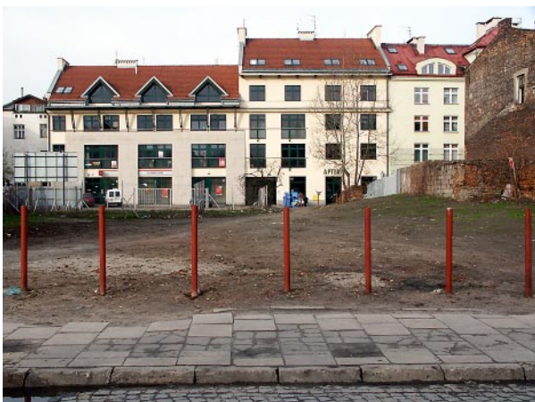
Kamienice przy ul. Kupa 3 i 5 (arch. P. Wróbel i M. Trela, 1998-1999)
