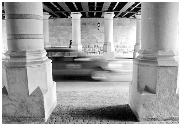
Kolumny kamienne dźwigające konstrukcję metalową wiaduktu kolejowego po konserwacji (Fot. I. Płuska)
