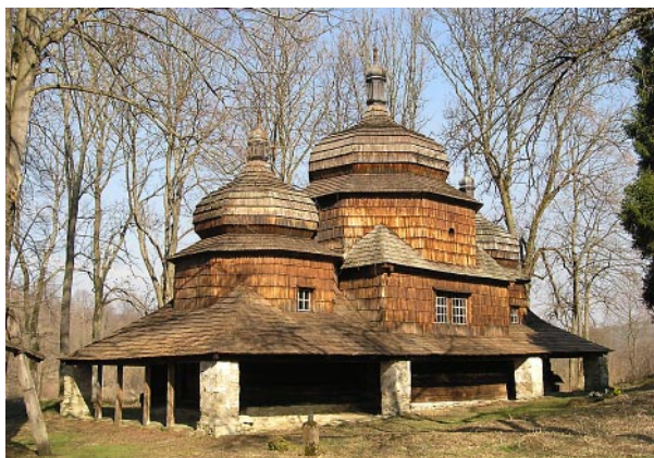
Piątkowa – dawna cerkiew greckokatolicka po pracach zabezpieczających
