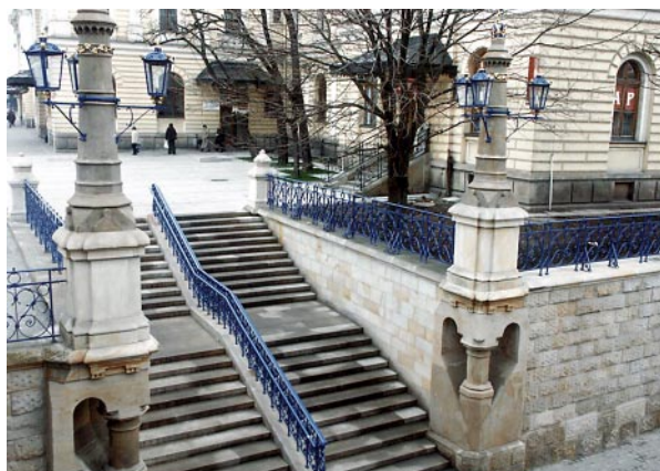
Widok schodów z obeliskami po konserwacji (Fot. I. Płuska)
