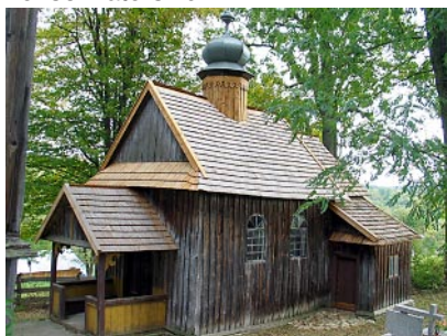
Koniusza – widok cerkwi po pracach konserwatorskich dachów
