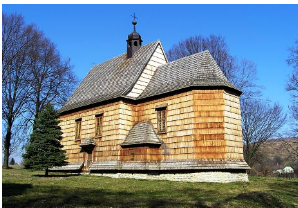
Bachórzec – widok kościoła po pracach konserwatorskich
