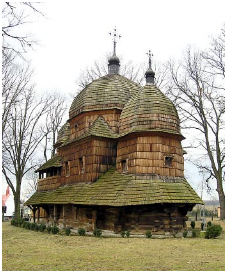
Chotyniec – widok cerkwi po pracach konserwatorskich
