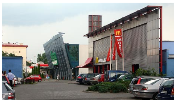
Supermarket Krakchemia (arch. DDJM, 1994-1995) i bar szybkiej obsługi (arch. W. Obtulowicz, 1996-1997)
