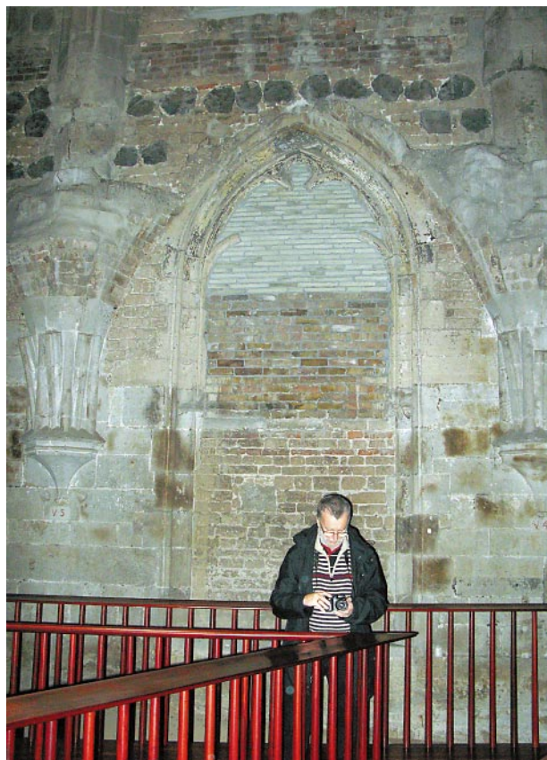
Ryc. 8. Zachowany fragment ściany wewnętrznej z gotyckiego kościoła św. Kolumby Fig. 8. Preserved fragment of the inside wall from the Gothic church of St. Columba
