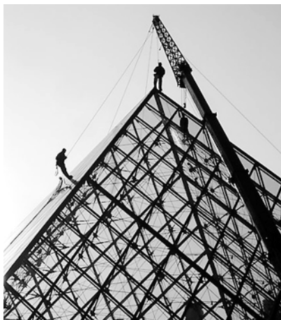
Ryc. 30. Ręczne mycie piramidy na dziedzińcu Louwru Fig. 30. Hand cleaning of the pyramid in the Louvre courtyard
