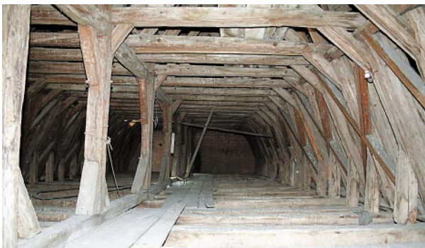
Ryc. 2. Widok ogólny konstrukcji dachu nad prezbiterium. Po bokach słupy (stolce) leżące, środkiem słupy posadowione na podciągu podłużnym leżącym na tramach Fig. 2. General view of the roof construction over the presbytery. On the sides reclining posts, in the centre posts resting on a binding joist lying on chords
