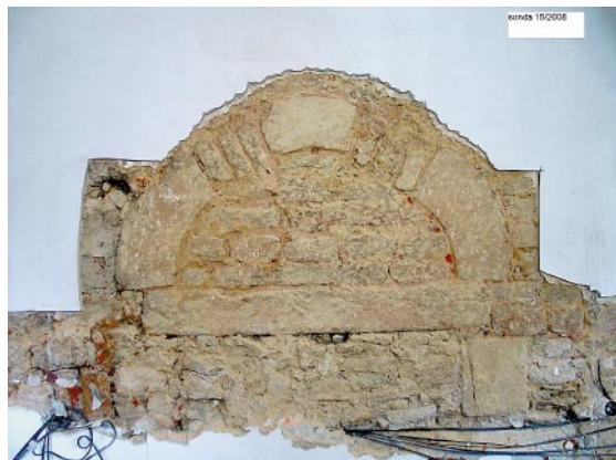
Ryc. 5. Portal północny. Fot. K. Stala
