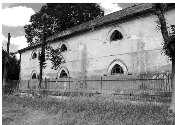
Ryc. 4. Trześń. Spichlerz, elewacja zachodnia Fig. 4. Trześń. Granary, west elevation
