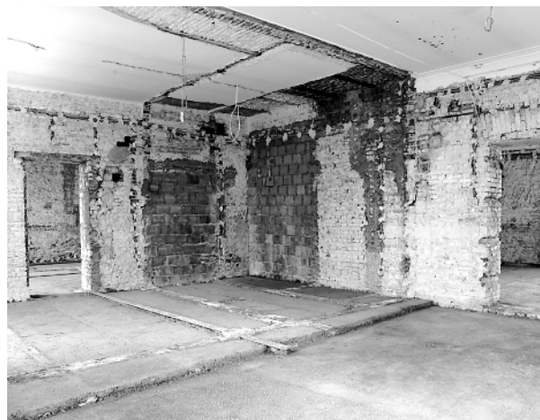
Ryc. 5. Zamek w Dzikowie – odtwarzana komnata z XVII wieku zachodniej części korpusu głównego – widoczne ślady wtórnych podziałów usuniętych w trakcie prac remontowych
