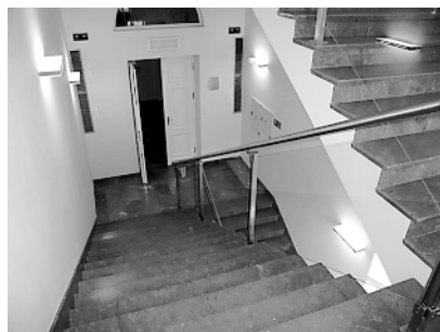
Ryc. 4. Szklana, całkowicie przezroczysta balustrada schodów może budzić niepokój w użytkownikach tej klatki schodowej Fig. 4. Entirely transparent glass railing in the stairwell can cause discomfort among the users of this staircase
