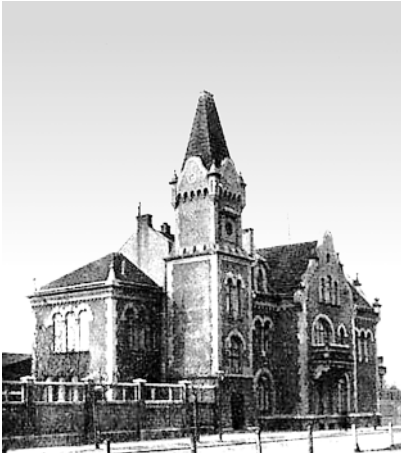
Ryc. 13. Szara Willa, stan budynku przed 1944 r. Fig. 13. The Gray Villa, state of the building from before 1944
