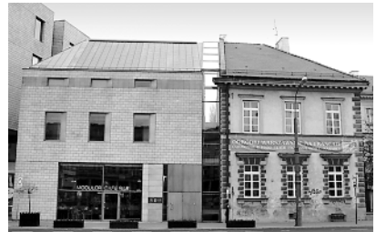
Ryc. 21. Rozdzielenie nowej i starej architektury za pomocą szklanej przegrody Fig. 21. Separating the new and the old architecture with a glass partition
