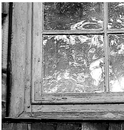
Ryc. 1. Dawne szkło w oknie starego, drewnianego kościołka to nie tylko przegroda, ale i element ożywiający fasadę Fig. 1. Old glass in the window of an old wooden church is not only partition but also an element enlivening the façade
