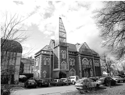
Ryc. 14. Uzupełnienia formy budynku wykonane w 1997 r. w konstrukcji szklano-metalowej Fig. 14. Fillings-in of the form of the building carried out in 1997 in glass-metal construction
