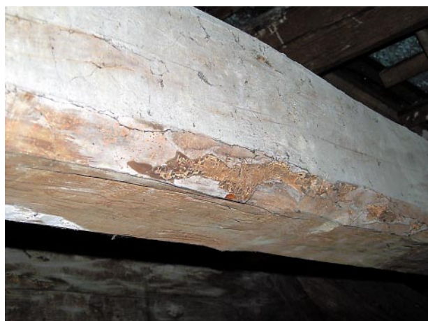
Ryc. 3, 4. Konstrukcja dachu i efekt żerowania owadów – technicznych szkodników drewna na elemencie więźby dachowej Fig. 3, 4. Roof construction and the effects of insects feeding – wood destroying pests on an element of rafter framing
