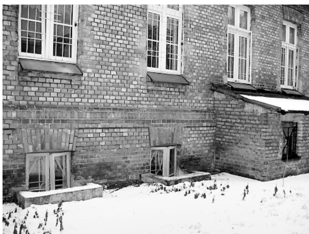
Ryc. 14, 15. Strefa przyziemia budynku. Stan techniczny cokołu, koszy okien piwnicznych. Brak prawidłowych izolacji przeciwwodnych i odprowadzenia wód opadowych [2] Fig. 14, 15. Basement zone of the building. Technical condition of the set-off and cellar windows embrasures. Lack of proper waterproofing and precipitation draining [2]
