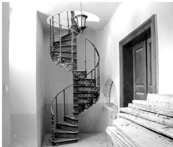
Ryc. 4. Zamek w Dzikowie – żeliwne schody na chór kaplicy z poł. XIX w.
