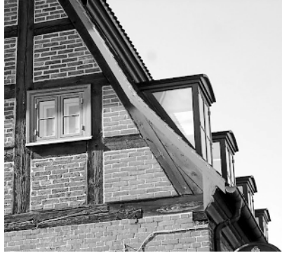
Ryc. 16. Nowoczesne lukarny o konstrukcji dopasowanej do architektury zabytku Fig. 16. Modern dormer windows with the construction matching the architecture of the historical building
