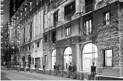
Ryc. 12. Sytuacja polepsza się znacznie w godzinach wieczornych, po włączeniu oświetlenia zainstalowanego za szkłem Fig. 12. Situation improves significantly towards the evening, after the lights installed behind the glass have been lit
