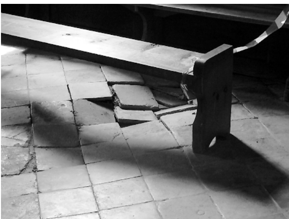
Ryc. 4. Binarowa. Przykładowe deformacje posadzki kościoła. Fot. Jan Janczykowski, czerwiec 2010 Fig. 4. Binarowa. Sample deformations of the church floor. Photo Jan Janczykowski, June 2010
