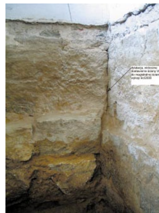
Ryc. 3. Widok na partię fundamentową ściany zachodniej. Fot. K. Stala
