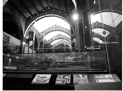
Ryc. 19. Barcelona, Muzeum Morskie – sposób przeszklenia gotyckich arkad – płytki szkła łączą małe metalowe elementy, a całość usztywniają szklane żebra Fig. 19. Barcelona, Maritime Museum – glazing of the Gothic arcades – glass sheets are joined with small metal elements and the whole is strengthened with glass ribs
