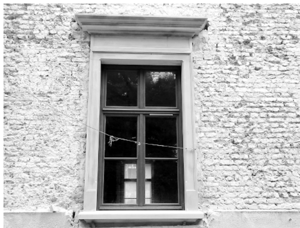
Ryc. 3. Zamek w Dzikowie – nowe obramowanie kamienne i okno zamontowane w elewacji wschodniej
