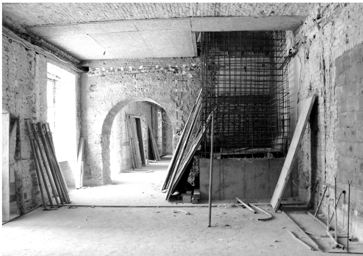
Ryc. 6. Zamek w Dzikowie – budowa szybu windy dla osób niepełnosprawnych we wschodniej części korpusu głównego
