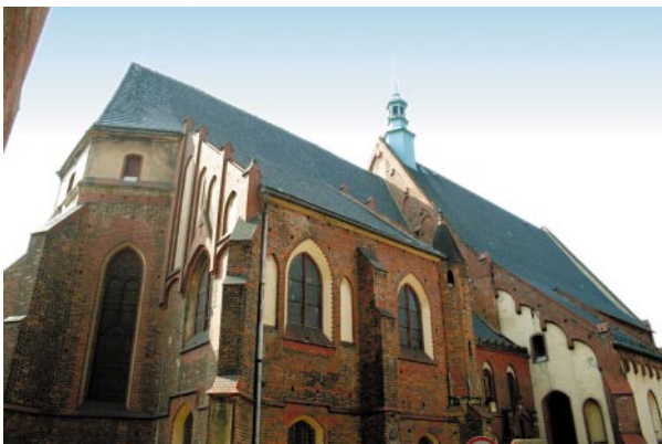
Ryc. 1. Prezbiterium kościoła – widok od strony północno-wschodniej. Przybudówka mieszcząca zakryście Fig. 1. The church presbytery – view from the north – east. The extension housing the vestry
