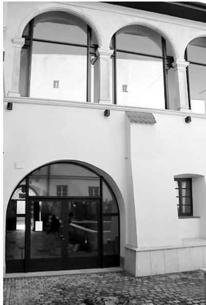
Ryc. 18. Nieodpowiednio rozwiązana nowa przegroda (podziały, materiał) wpływa silnie na odbiór zabytkowej architektury. Przypadkowe odbicia w szkłe wzmacniają negatywne oddziaływanie przegrody na zabytkowy klimat tego renesansowego wnętrza Fig. 18. Inappropriately solved new partition (division, material) strongly influences the viewer's reception of historic architecture. Incidental reflections in the glass increase the negative impact of the partition on the historical atmosphere of the Renaissance interior
