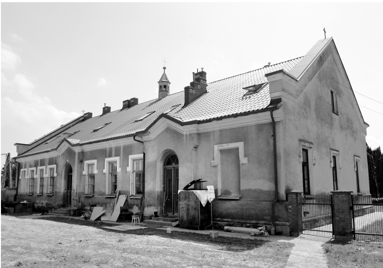
Ryc. 1. Tarnobrzeg Wielowieś. Budynek dawnej szkoły Fig. 1. Tarnobrzeg Wielowieś. Building of the former school
