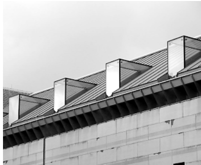
Ryc. 17. Nowe lukarny, wykonane z całkowicie bezbarwnego szkła Fig. 17. New dormer windows made from colourless glass
