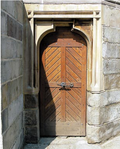
Ryc. 21. Portal wejściowy do dzwonnicy – ostateczny widok po konserwacji (rok 2011) Fig. 21. Entrance portal to the bell tower – final view after conservation (2011)
