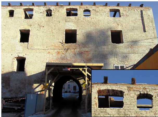
Ryc. 27. Południowy odcinek elewacji zachodniej skrzydła zachodniego (z fazy II) po skuciu tynków. Nad bramą wjazdową (z fazy IV) widoczny ślad po poprzedzającym ją pierwotnie budynku bramnym. W prawym dolnym narożniku otwory okienne najwyższej kondygnacji: mniejszy – gotycki z fazy II, większy – z fazy V, z wręgami po deskowym nadprożu. Fot. L. Wawrykiewicz, 2010 Fig. 27. The southern section of the west elevation of the west wing (from phase II) after hacking off plaster. Over the entrance gate (from phase IV) visible traces of the preceding original gatehouse. In the bottom right corner window openings of the top storey: the smaller – Gothic from phase II, the larger – from phase V, with traces of plank lintel. Photo by L. Wawrykiewicz, 2010
