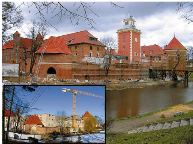
Ryc. 22. Przedzamcze w widoku od południowego zachodu w trakcie prac. W lewym dolnym narożniku ten sam widok przed budową wieży, nadbudową międzymurza południowego oraz baszty południowo-zachodniej. Fot. L. Wawrykiewicz, 2010 i 2011 Fig. 22. The bailey during the work – view from the south-west. In the left bottom corner the same view before erecting the tower, and raising of the south intermural space and the south-west tower. Photo by L. Wawrykiewicz, 2010 and 2011
