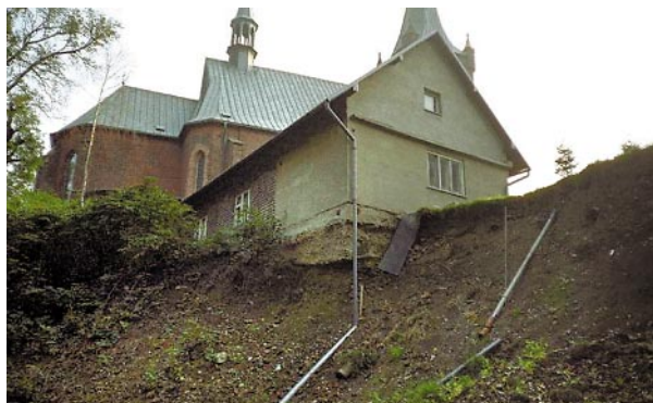
Ryc. 10. Przykład lokalnej utraty stateczności: wzgórze kościoła pw. św. św. Jerzego i Wojciecha w Zatorze (zdjęcie: Zbigniew Pająk) Fig.10. An example of local loss of stability, the hill of St. George and St. Wojciech's Church in Zator (photo: Pająk Zbigniew)
