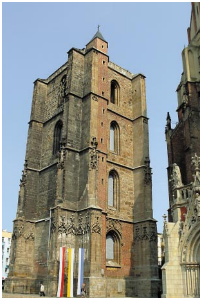
Ryc. 15. Elewacja południowo-zachodnia (rok 2011) Fig. 15. South-western elevation (2011)
