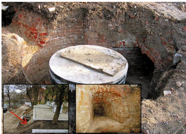
Ryc. 25. Relikty południowej baszty przedbramia zachodniego z fazy IV w trakcie prac ziemnych, związanych z wykonaniem instalacji. W dole od prawej: strzelnica baszty oraz widok miejsca, w którym odkryto relikty baszty, już po wykonaniu nawierzchni parkingów. Fot. L. Wawrykiewicz, 2011 Fig. 25. Relics of the south tower of the west foregate from phase IV during earthworks connected with putting in installations. Bottom right: tower embrasure and view of the site where relics of the tower were discovered, after the parking lot surface had been laid. Photo by L. Wawrykiewicz, 2011
