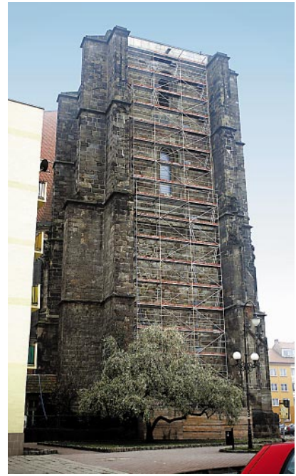
Ryc. 36. Elewacja od strony północno-zachodniej – prace konserwatorskie prowadzone w 2010 roku
