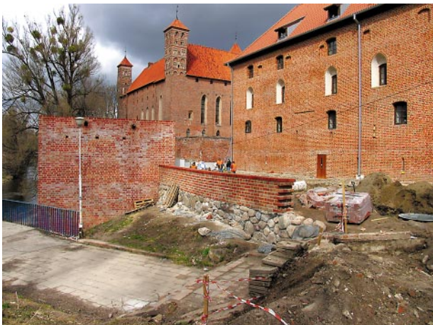
Ryc. 21. Mur zewnętrzny międzymurza zachodniego oraz baszta ustępowa po nadbudowie w ramach adaptacji przedzamcza (mur międzymurza dobiega do późniejszej od niego baszty i jest wykonany z cegły wyłącznie w partii zwieńczenia w formie płytkiego murka). Fot. L. Wawrykiewicz, 2011 Fig. 21. The outer wall of the west intermural space and the privy tower after it was raised during the adaptation of the bailey (the wall of the intermural space adjoins the tower from a later period, and is made from brick only in the part of its coping in the form of a shallow wall). Photo by L. Wawrykiewicz, 2011
