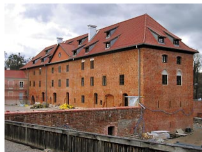
Ryc. 13. Skrzydło zachodnie po remoncie (jeszcze z blendą na północnym skraju przyziemia). Fot. L. Wawrykiewicz, 2011
