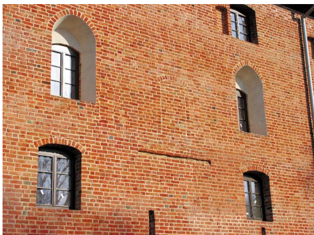
Ryc. 15. Północny odcinek elewacji zachodniej skrzydła zachodniego (faza II) po remoncie (bez śladów pobiałej wyznaczającej zarys ganku oraz z przemurowanymi w regularne narożniki ościeżami wtórnych otworów). Fot. L. Wawrykiewicz, 2011
