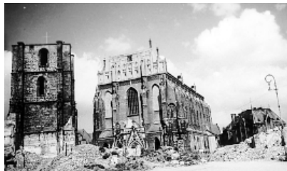
Ryc. 5. Zniszczenia kościoła farnego i dzwownicy oraz otaczających zabudowań (początek lat 50. XX w.) Ryc. 5. Damage to the parish church, bell tower and the surrounding buildings (beginning of the 1950s)
