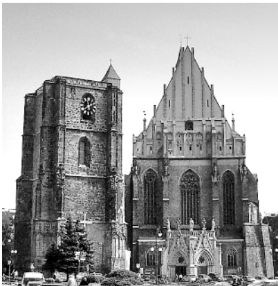
Ryc. 2. Widok z płyty Rynku, od południowego zachodu na zespół kościoła farnego (rok 2011) Fig. 2. View from the Market Square, from the south-west, onto the parish church complex (2011)
