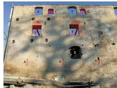
Ryc. 10. Północny odcinek elewacji zachodniej skrzydła zachodniego (faza II) po skuciu tynków. A – strzelnice szczelinowe; B – ostrołukowe blendy piętra, w których znajdowały się otwory zamknięte odcinkiem łuku; C – otwory obronne poddasza; D – otwór wyjściowy na ganek prowadzący do ustępu (wokół pobiała określająca zarys ganku, w tym dwuspadowego daszku); E – wtórne otwory z fazy V; F – wtórne otwory z etapu I fazy VI. Fot. L. Wawrykiewicz, 2010
