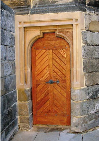
Ryc. 20. Portal wejściowy do dzwonnicy – widok po częściowej konserwacji z 2004 roku Fig. 20. Entrance portal to the bell tower – view after partial conservation in 2004
