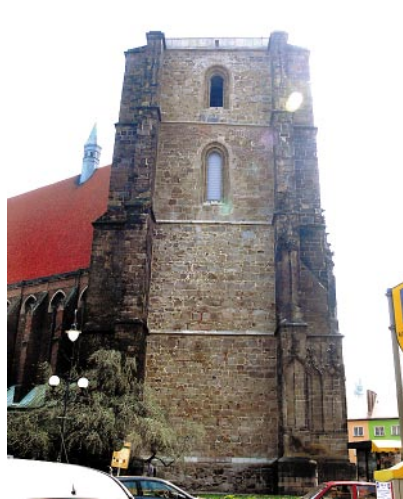
Ryc. 14. Elewacja północno-zachodnia (rok 2011) Fig. 14. North-western elevation (2011)
