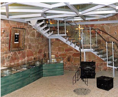
Ryc. 22. Najniższa kondygnacja galerii wystawienniczej, widoczna samonośna konstrukcja stalowa, schody oraz wymieniona posadzka wykonana jako brukowana z kostek granitowych (rok 2011) Fig. 22. The lowest storey of the exhibition gallery, with visible self-supporting steel construction, stairs and replaced flooring made from granite cobblestones (2011)
