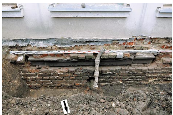
Ryc. 10. Lublin, klasztor powizytkowski, kościół, fasada północna. Wykop 6/10, część środkowa. Lico północne muru fundamentowego fasady północnej z zachowanym piaskowcowym progiem kościoła Wizytek. Nad progiem widoczne przemurowania związane z likwidacją otworu wejściowego, widok na S. Fot. R. Solski, 11.08.2010 r.
