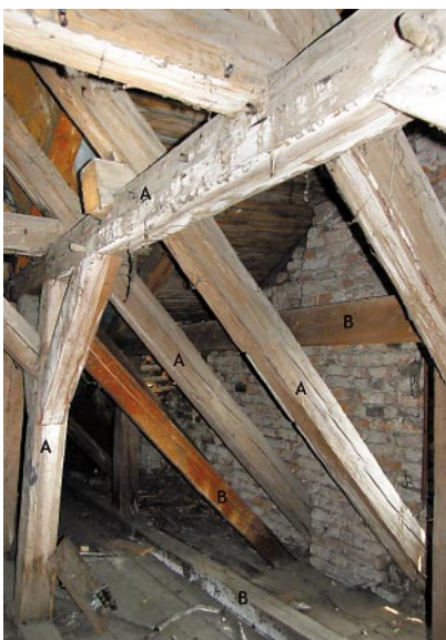
Ryc. 35. Więźba dachowa skrzydła zachodniego przed demontażem w ramach adaptacji na hotel. A – elementy ciosane z etapu I fazy VI; B – elementy tarte z etapu I fazy VII. Fot. L. Wawrykiewicz, 2008
