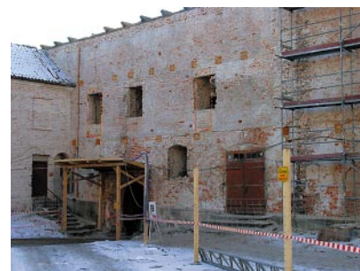
Ryc. 11. Południowy odcinek elewacji wschodniej (dziedzińcowej) skrzydła zachodniego (faza II) po skuciu tynków. Na piętrze ślady po otworach drzwiowych, poniżej i powyżej nich gniazda po belkach drewnianego krużganka lub ganku (niekiedy z pozostałościami belek). W zwieńczeniu elewacji mur pełny zakończony rolką (w ramach remontu zostały w nim wykute od podstaw otwory okienne). W dole ślady po pierwotnych otworach drzwiowych (zamkniętych ostrołukowo) oraz okiennych (zamkniętych odcinkiem łuku), a także otwór bramny z fazy IV. Fot. L. Wawrykiewicz, 2010
