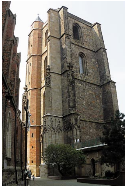
Ryc. 16. Elewacja północno-wschodnia (rok 2011) Fig. 16. North-eastern elevation (2011)
