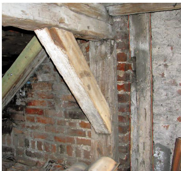
Ryc. 10. Poddasze wieży z widocznymi relikwami słupów gotyckiej konstrukcji dachu Fig. 10. Tower loft, with visible relics of posts of the Gothic roof construction
