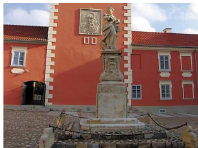
Ryc. 38. Pomnik św. Katarzyny oraz elewacja dziedzińcowa skrzydła południowego po remoncie (z jednolitym detalem architektonicznym, utrzymanym w stylistyce baroku klasycyzującego). W boniowaniu narożnym wieży podcięcia wykonane pod blendę i otwór po XIX-wiecznych otworach okiennych (z etapu I fazy VII). Fot. L. Wawrykiewicz, 2011
