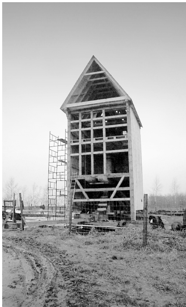
Ryc. 15. Bierzysłowo, wiatrak koźlak z 1867 r. Widok ściany wejściowej po przeprowadzonych pracach konserwatorskich. Stan z listopada 2010 r. (fot. M. Prarat, 2010)
