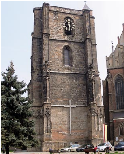
Ryc. 13. Elewacja południowo-wschodnia (rok 2011) Fig. 13. South-eastern elevation (2011)
