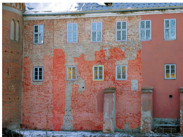
Ryc. 18. Południowy odcinek elewacji wschodniej skrzydła wschodniego po skuciu tynków. Kolorem czerwonym podkreślono relikty gotyckie: ciemniejszym – z fazy II, jaśniejszym – z etapu I fazy III. Liniami czerwonymi zaznaczono szwy po gotyckich otworach okiennych z fazy II, jasnozielonymi – z fazy V, jasnofioletowymi – z etapu I fazy VI, ciemnofioletowymi – z etapu II fazy VI, żółtymi – z etapu II fazy VII. Czarną linią przerywaną podkreślono szew między murami z fazy V oraz w górnej partii z etapu I fazy VI (po prawej), a murami z etapu II fazy VI (po lewej). Fot. L. Wawrykiewicz, 2010
