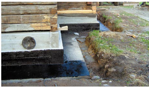
Ryc. 12. Wzmocnienie fundamentów kościoła pw. św. Rocha w Radomsku (zdjęcie: autor) Fig.12. Reinforcing the foundations of the St. Roch Church in Radomsko (photo: author)
