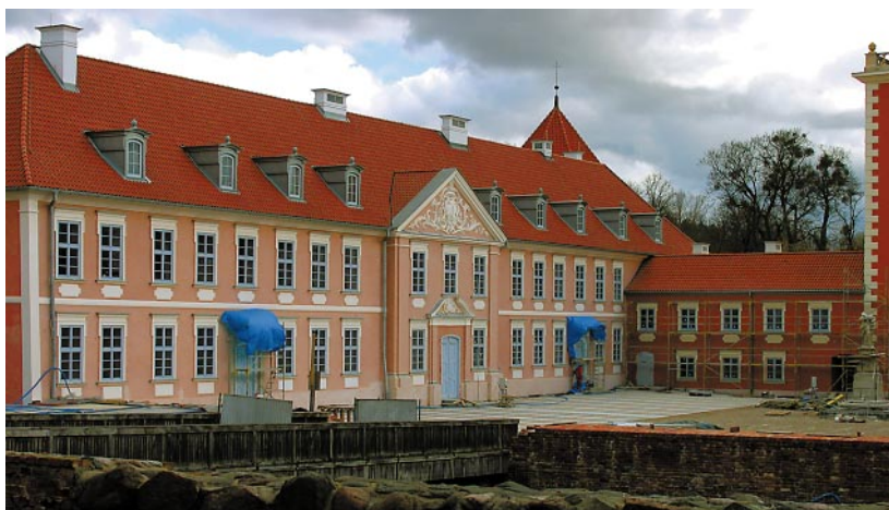
Ryc. 33. Elewacja dziedzińcowa skrzydła wschodniego po remoncie. Fot. L. Wawrykiewicz, 2011
