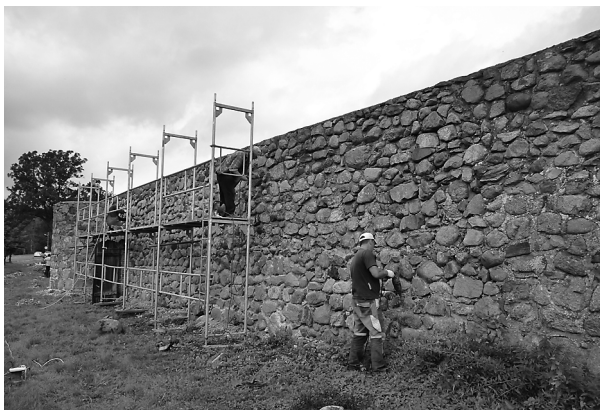
Fot. 18. Usuwanie pozostałości po mocnych zaprawach cementowych Photo 18. Removing remains of strong cement mortars
