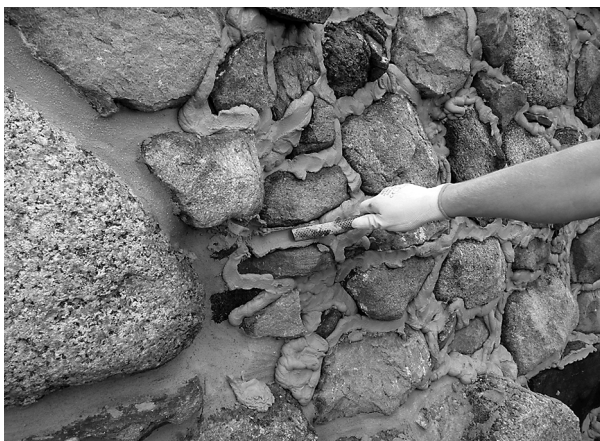
Fot. 21. Po ok. 1-2 godzin można przystąpić do dalszej obróbki zaprawy TKF Photo 21. After app. 1-2 hours, TKF mortar can be further processed
