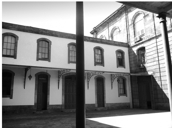
Fot. 22. Budynek Alfandega Nova. Widok na fragment dziedzińca wewnętrzny, fot. D. Kuśnierz-Krupa, 09.2012 Photo 22. The building of Alfandega Nova. View of a fragment of the inner courtyard, photo by D. Kuśnierz-Krupa, 09.2012
