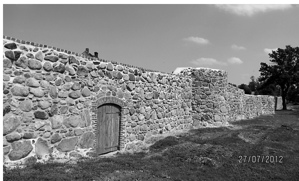
Fot. 24. Mury po renowacji Photo 24. Walls after renovation
