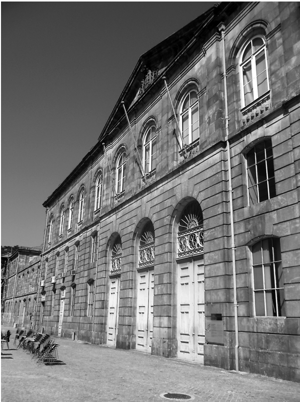
Fot. 2. Widok na fragment elewacji Alfandega Nova w Porto od strony rzeki Douro, fot. D. Kuśnierz-Krupa, 09.2012 Photo 2. View of the elevation fragment of Alfandega Nova in Porto from the river Douro, photo by D. Kuśnierz-Krupa, 09.2012
