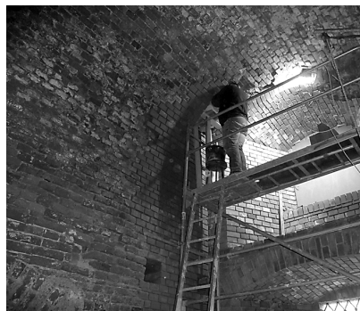
Fot. 11. Sklepienie podczas renowacji Photo 11. Vault during renovation
