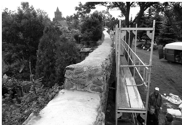
Fot. 22. Warstwa spadkowa na koronie muru z zaprawy murarskiej TWM Photo 22. Sloping layer on the wall top from TWM masonry mortar
