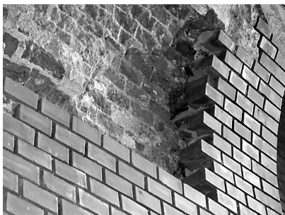
Fot. 10. Sklepienie podczas renowacji Photo 10. Vault during renovation
