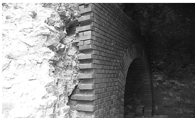
Fot. 8. Ściana podczas renowacji Photo 8. Wall during renovation
