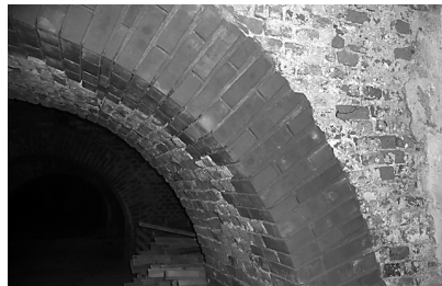
Fot.14. Łuk po renowacji Photo 14. Brick arch after renovation
