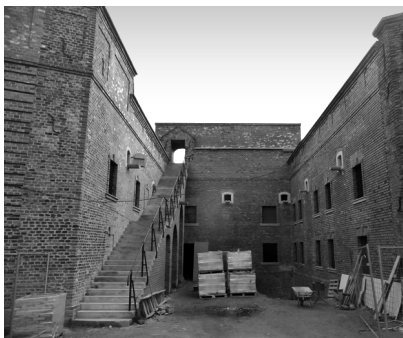
Fot. 5. Elewacja donżonu po renowacji, zastosowano zaprawę murarską TZM-s Photo 5. Elevation of the Donjon after renovation, TZM-s mortar was applied
