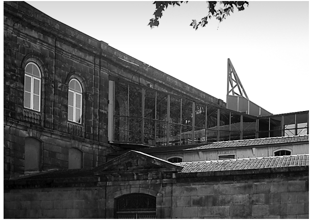
Fot. 4. Widok na fragment elewacji Alfandega Nova, gdzie zastosowano współczesne detale architektoniczne, fot. D. Kuśnierz-Krupa, 09.2012 Photo 4. View of the elevation fragment of Alfandega Nova, where modern architectural details were used, photo by D. Kuśnierz-Krupa, 09.2012
