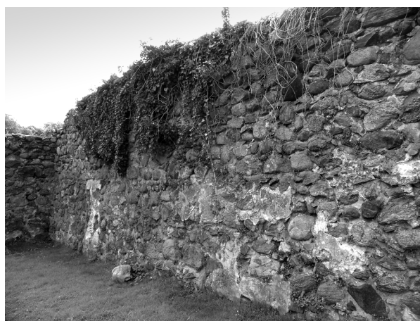
Fot. 17. Mury obronne przed renowacją Photo 17. Defensive walls before renovation
