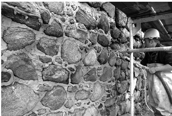
Fot. 20. Spoinowanie muru zaprawą TKF, aplikacja mechaniczna Photo 20. Sealing joints in the wall with TKF mortar, mechanical application
