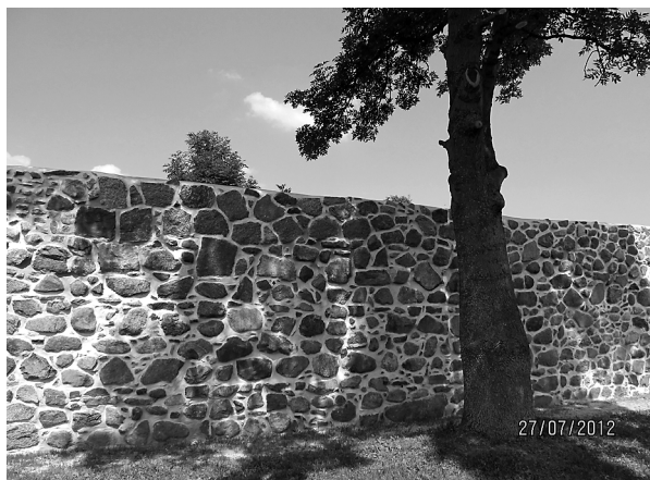
Fot. 25. Mury po renowacji Photo 25. Walls after renovation
