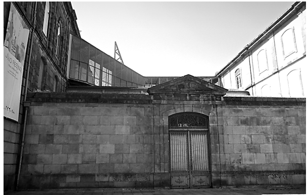
Fot. 5. Widok na fragment elewacji Alfandega Nova, gdzie zastosowano współczesne detale architektoniczne, fot. D. Kuśnierz-Krupa, 09.2012 Photo 5. View of the elevation fragment of Alfandega Nova, where modern architectural details were used, photo by D. Kuśnierz-Krupa, 09.2012
