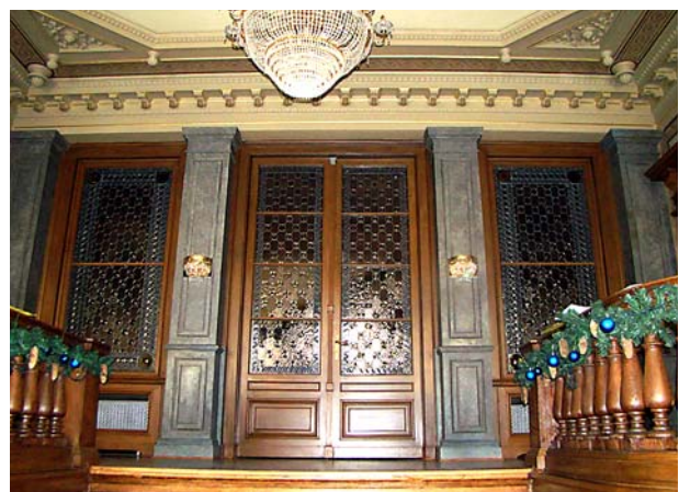
Ryc. 6. Hol wejściowy: stolarka mazerowana, filary z imitacją granitu, witraże, strop sztukatorski po pracach konserwatorskich, 2011 r. Fot. D. Kowalik-Kociszewska Fig. 6. Entrance hall: marbleized joinery, pillars with granite imitation, stained glass, stucco ceiling after conservation work, 2011. Photo by D. Kowalik-Kociszewska
