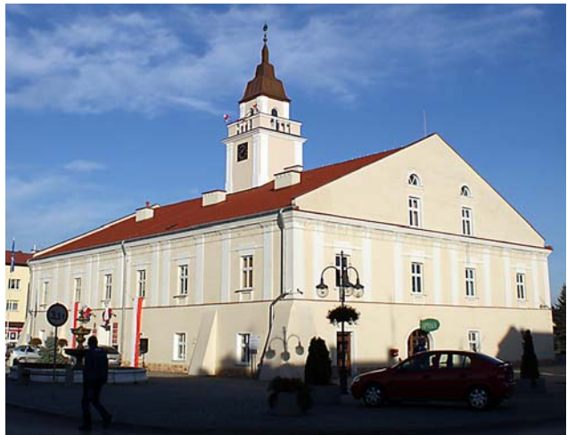
Ryc. 10. Ratusz po interwencji projektowej. Widok od strony południowo-zachodniej fot. D. Kuśnierz-Krupa, 2012
