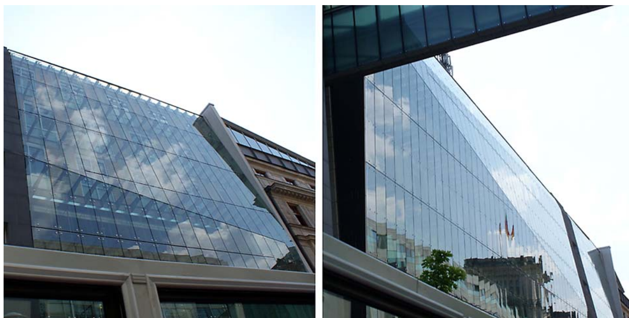
Ryc. 2. Budynek mieszkalny w Berlinie – dodatkowa warstwa szkła przy ruchliwej ulicy – widok w skali ulicy (fot. Ł. Wesółowski) Fig. 2. Residential building in Berlin – additional glass screen in a busy street – view in the scale of the street (photo by Ł. Wesółowski)
