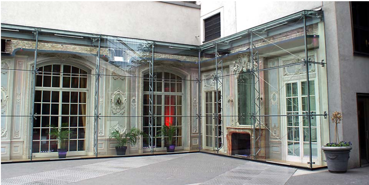
Ryc. 3. Zabytkowa fasada budynku w Berlinie – Poprawa parametrów termicznych i jednoczesna ochrona historycznych detali dzięki przejrzystej fasadzie z punktowym mocowaniem szyb (fot. Ł. Wesółowski)
