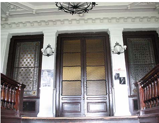
Ryc. 5. Hol wejściowy przed rozpoczęciem prac, 2007 r. Fot. J. Szot Fig. 5. Entrance hall before commencing work, 2007. Photo by J. Szot
