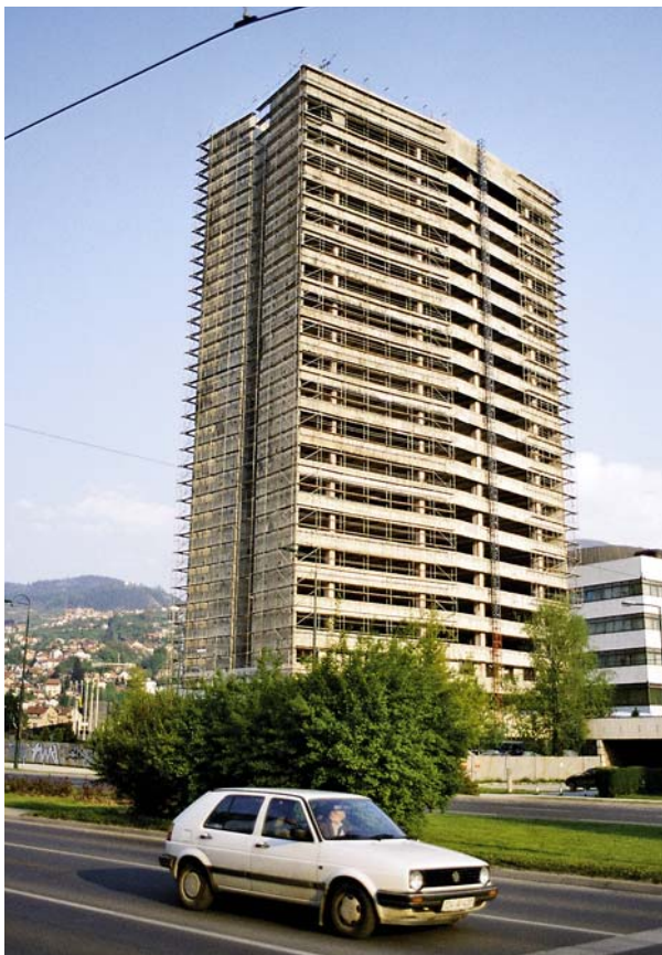
Ryc. 9. Odbudowa dawnego budynku Parlamentu w Sarajewie, fot. M. Żyła Fig. 9. Reconstruction of the old Parliament building in Sarajevo, photo: M. Żyła
