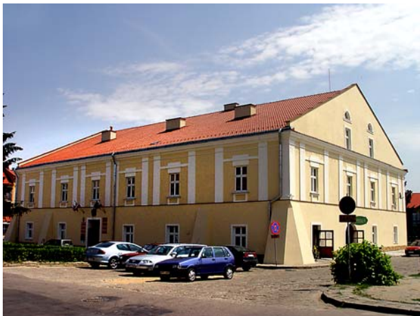
Ryc. 3. Widok ratusza od strony południowo-zachodniej przed interwencją projektową, fot. D. Kuśnierz-Krupa, 2006
