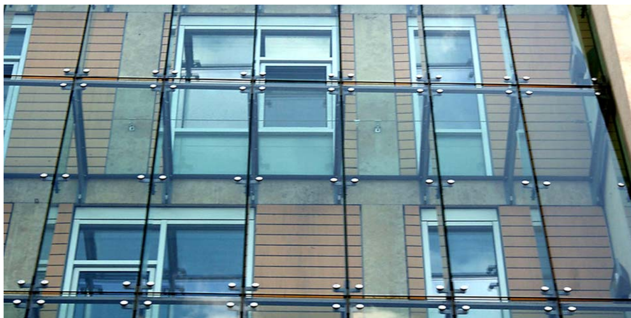
Ryc. 1. Budynek mieszkalny w Berlinie – podwójna fasada ze ścianą osłonową przy ruchliwej ulicy – detal (fot. Ł. Wesółowski) Fig. 1. Residential building in Berlin – a double facade with an outer glass wall in a busy street – detail (photo by Ł. Wesółowski)
