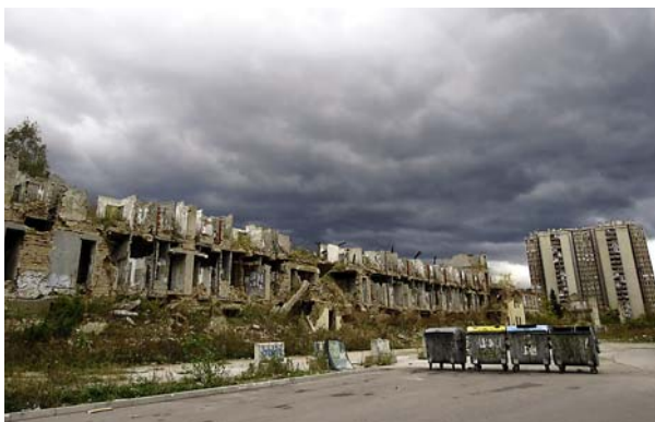
Ryc. 7. Zniszczenia w obrębie peryferyjnych dzielnic Sarajewa, fot. M. Żyła Fig. 7. Destruction on the outskirts of Sarajevo, photo: M. Żyła
