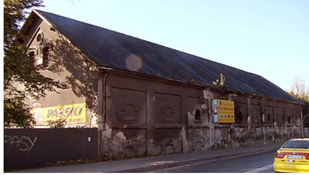
Ryc. 3. Relikty browaru parowego w Skawinie, widok od strony ul. Mickiewicza, fot. M. Krupa, 2010 Fig. 3. Relics of the steam brewery in Skawina, view from Mickiewicza Street, photo M. Krupa, 2010
