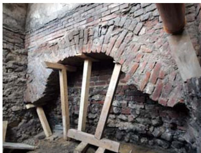
Ryc. 15. Warstwa opłaszczowania późnoromańskiej ściany zachodniej krużganka wykonana od strony dziedzińca gospodarczego, po wyburzeniu skrzydła zachodniego, wsparta na niezależnym łukowym fundamentcie. Fot. A. Bojęś-Białasik
