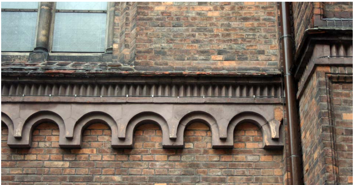
Ryc. 1. Kościół Najświętszego Serca Pana Jezusa, ss. Szarytek, fryz arkadkowy z terakotowych kształtek Fig. 1. The church of the Most Sacred Heart of Jesus, Sisters of Charity, arcaded frieze from terracotta profiles
