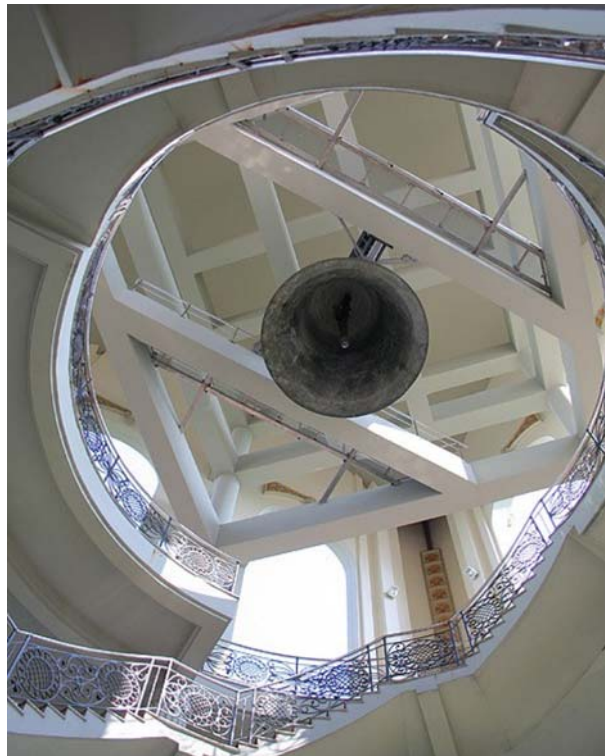
Ryc. 14. Usytuowanie dzwonu wewnątrz wieży
