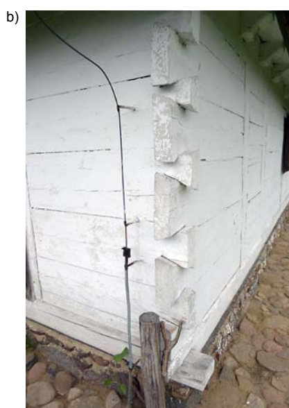
Ryc. 4a. Sposoby łączenia ścian wieńcowych w narożach: na zakładkę prostą z ostatekami i bez
