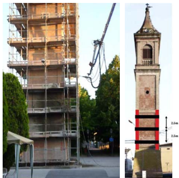
Ryc. 7. Wzmacnianie dzwonnicy: a) natrysk materiału FRC, b) owinięcie materiałem FRP
