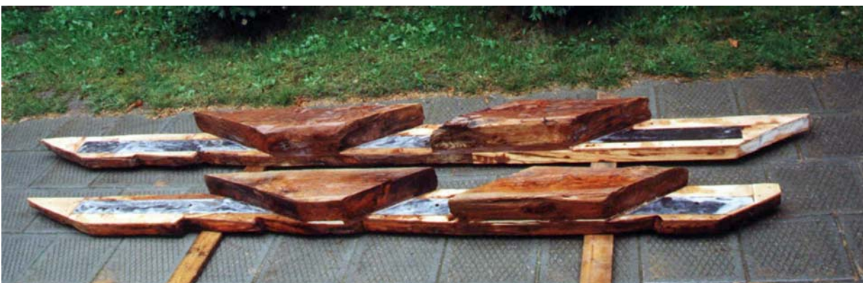
Ryc. 27. Zastrzały wzmocnione za pomocą wklejonych płaskowników stalowych
