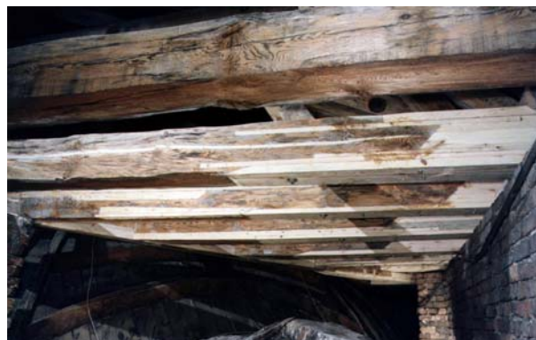
Ryc. 22. Zrekonstruowane podwaliny i belki stropowe. Widok z dołu Fig. 22. Reconstructed ground beams and floor beams tips – bottom view
