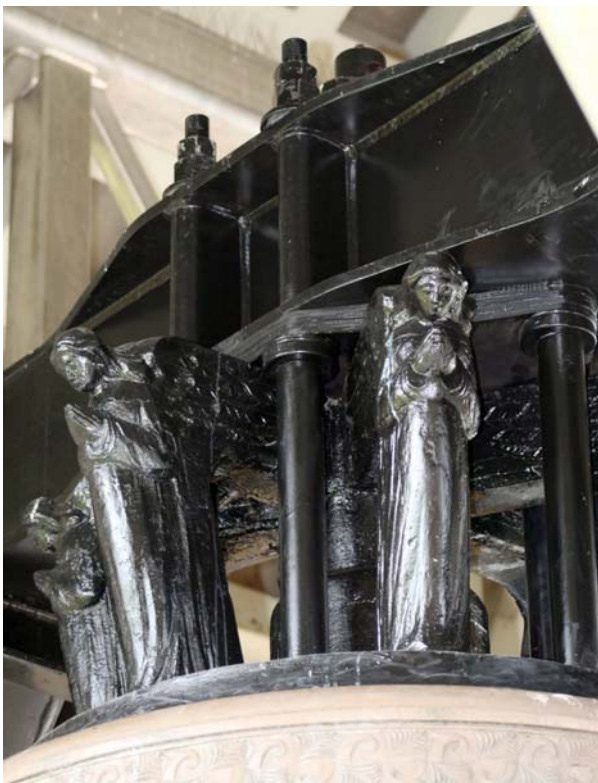
Ryc. 33. Detal połączenia nowego jarzma z dzwonem – widok z dołu
