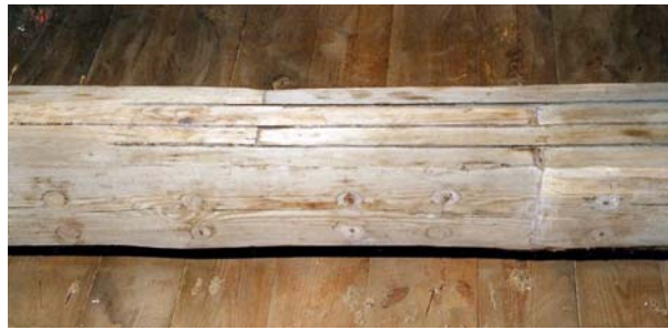
Ryc. 4. Wykonane połączenie belek na zwidłowanie wzmacnione pionowymi blachami stalowymi Fig. 4. Completed finger joint between beams reinforced with vertical steel plates
