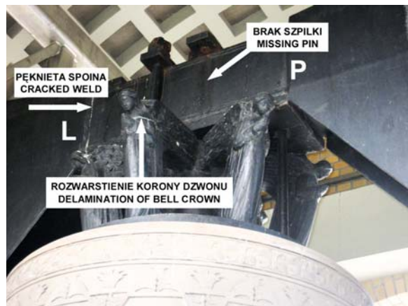
Ryc. 10. Dzwon Józef wiszący na 5 szpilkach Fig. 10. Józef bell hanging on 5 pins
