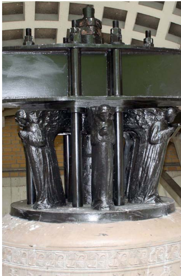
Ryc. 32. Detal połączenia nowego jarzma z dzwonem – widok z boku
