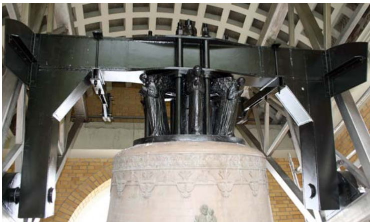
Ryc. 35. Dzwon Józef zawieszony na nowym jarzmie – widok z wnętrza dzwonnicy
