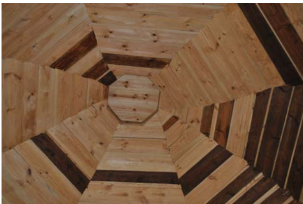
Ryc. 6. Widok wyremontowanej konstrukcji sklepienia sanktuarium, 2015, fot. Ł. Gołda
