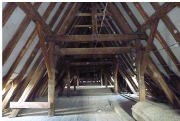
Ryc. 2. Widok więźby dachowej nad nawą główną
