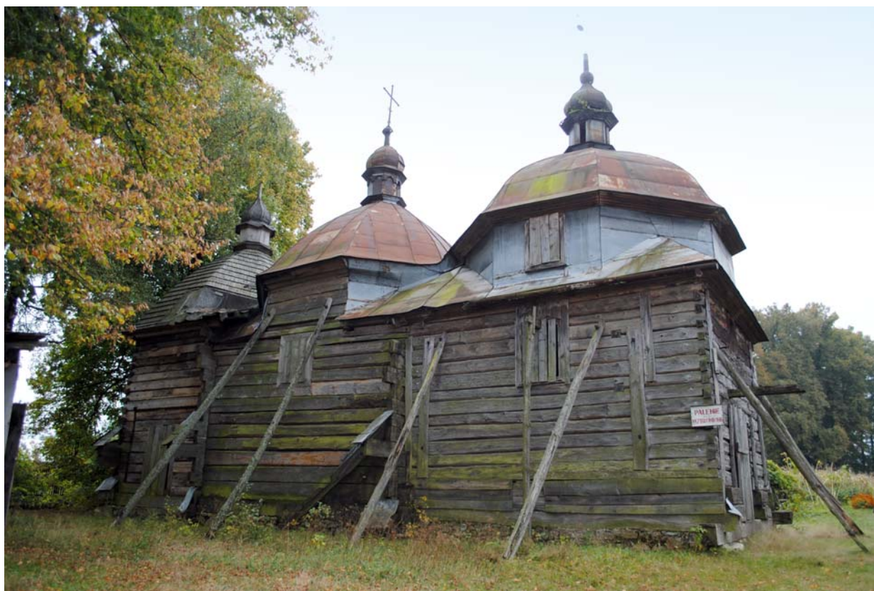
Ryc. 2. Widok ogólny cerkwi, strona północna, 2013, fot. Ł. Gołda
