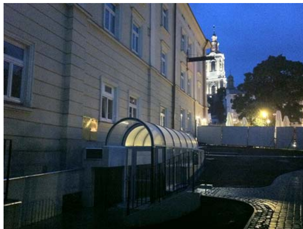
Ryc. 6. Nowoczesne wejście do piwnic. Fot. M. Piórkowski Fig. 6. Modern entrance to the cellars. Photo: M. Piórkowski
