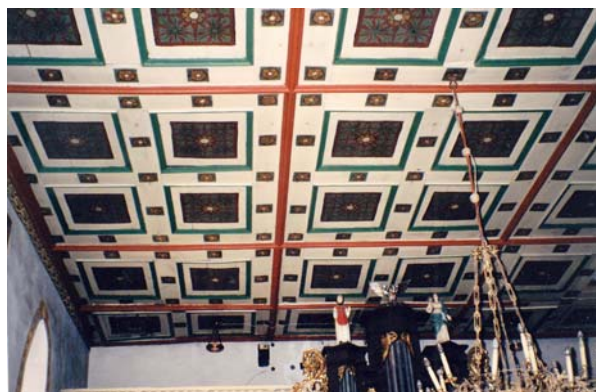
Ryc. 18. Widok pułapu ramowo-płycinowego z przemalowaniem z 1937–38 r. przed pracami konserwatorskimi (fot. ks. W. Dokurno) Fig. 18. View of the panel-framed ceiling repainted in 1937–1938, prior to conservation work (photo: Fr. W. Dokurno)
