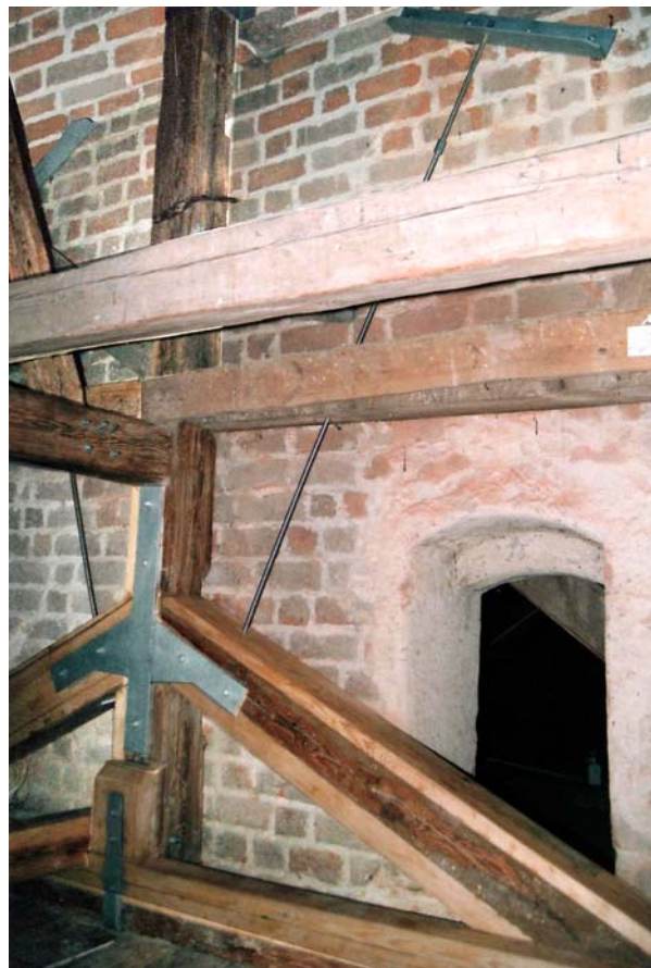
Ryc. 28. Zawieszenie wiazara na ścianie tęczowej
