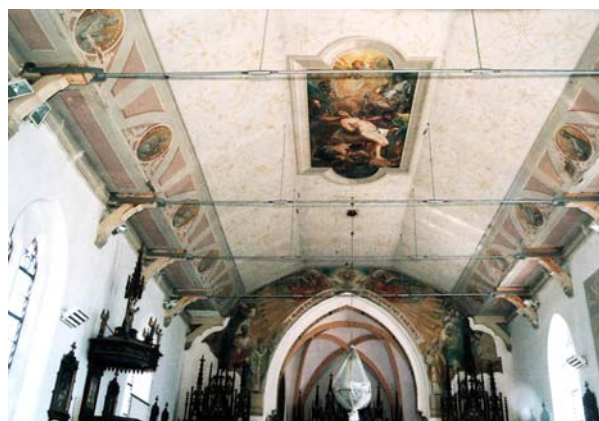
Ryc. 29. Wnętrze nawy po zainstalowaniu ściągow
