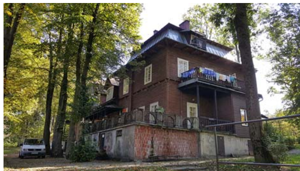
Ryc. 10. Willa „Lilianna” obecnie. Widok elewacji tylnej oraz bocznej od północnego zachodu. Fot. M. Krupa, 2017
