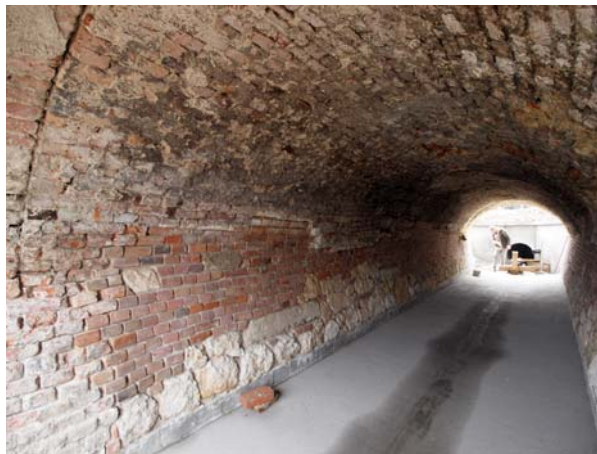
Ryc. 13. Kanał pod budynkiem barokowym po restytucji ścian podłużnych
