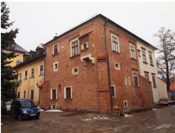
Ryc. 4. Przeoriat, widok od południowego zachodu; na elewacji zachodniej widoczny wykusz z dawną latryną, na elewacji południowej para małych okienek doświetlających latryny usytuowane na poziomie podwyższonego parteru
