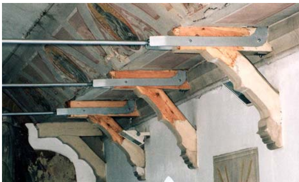
Ryc. 26. Montaż ściągow do konsoli podpierających pseudosklepienie
