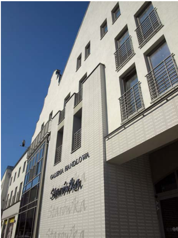
Ryc. 3. Elewacja zespołu, w tym Galeria Handlowa Starówka, fot. z archiwum Jacka Lenarta
