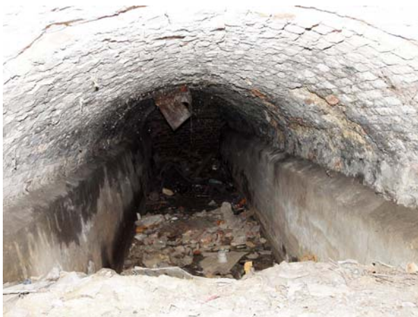
Ryc. 9. Wnętrze kanału wodnego pod budynkiem barokowym przed rozpoczęciem prac
