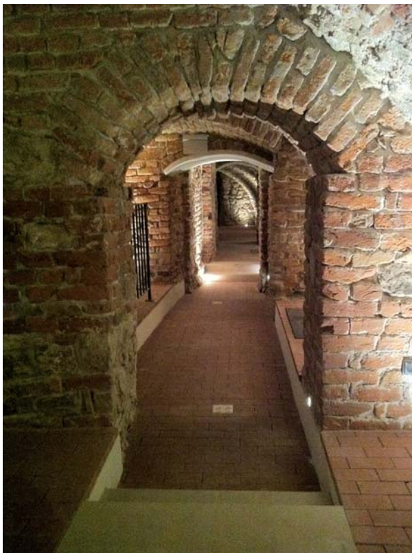
Ryc. 3. Restauracja ciągów komunikacyjnych pomiędzy komorami piwnic. Fot. M. Piórkowski
