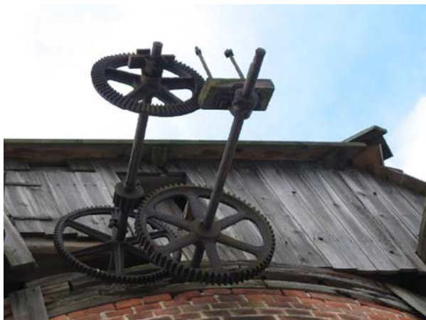
Ryc. 3. Łąkorz, wiatrak „holender”, strefa głowicy, relikty mechanizmu napędowego głowicy, widok z poziomu gruntu, stan obecny. Fot. J. Kielar, lipiec 2011
