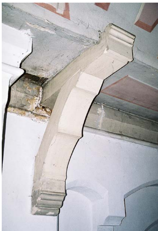
Ryc. 14. Konsola wspierająca pseudokopułę Fig. 14. Console supporting pseudo-vaulting
