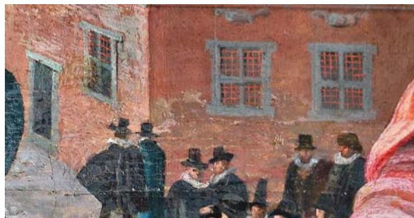
Ryc. 13. Przyziemie ratusza w pd.-wsch. części z nieistniejącym wejściem do Komory Palowej oraz malowanymi na czerwono kratami w oknach, fot. K. Darecka, 2015
