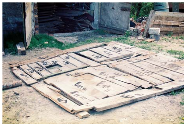
Ryc. 16. Stan techniczny pola płycinowego nad chórem muzycznym. Widok od góry przed pracami restauratorskimi, fot. ks. W. Dokurno Fig. 16. The technical condition of panel fields above the choir gallery. View from above prior to renovation work, photo: Fr. W. Dokurno)
