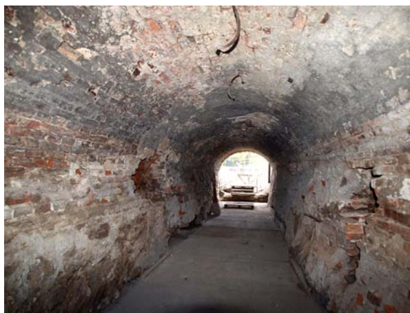
Ryc. 10. Wnętrze kanału pod budynkiem barokowym po wykonaniu płyty dennej i przed konserwacją ścian i sklepienia
