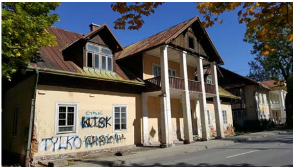
Ryc. 7. Willa „Pod Luboniem” obecnie. Widok elewacji frontowej od południowego zachodu. Fot. M. Krupa, 2017
