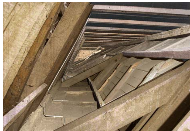
Ryc. 12. Konstrukcja pseudokopuły – widok od strony poddasza Fig. 12. Pseudo-vaulting structure – view from the attic side
