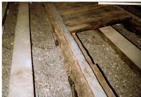
Ryc. 4. Podłoga fryzowa w trakcie ponownego układania. Widoczny fragment zabytkowych desek oraz legary i keramzyt, fot. ks. W. Dokurno
