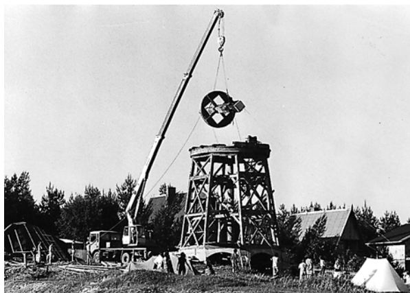
Ryc. 2. Montaż konstrukcji wiatraka w Studziankach – 14.07.1986 (fot. B. Topczewski)
