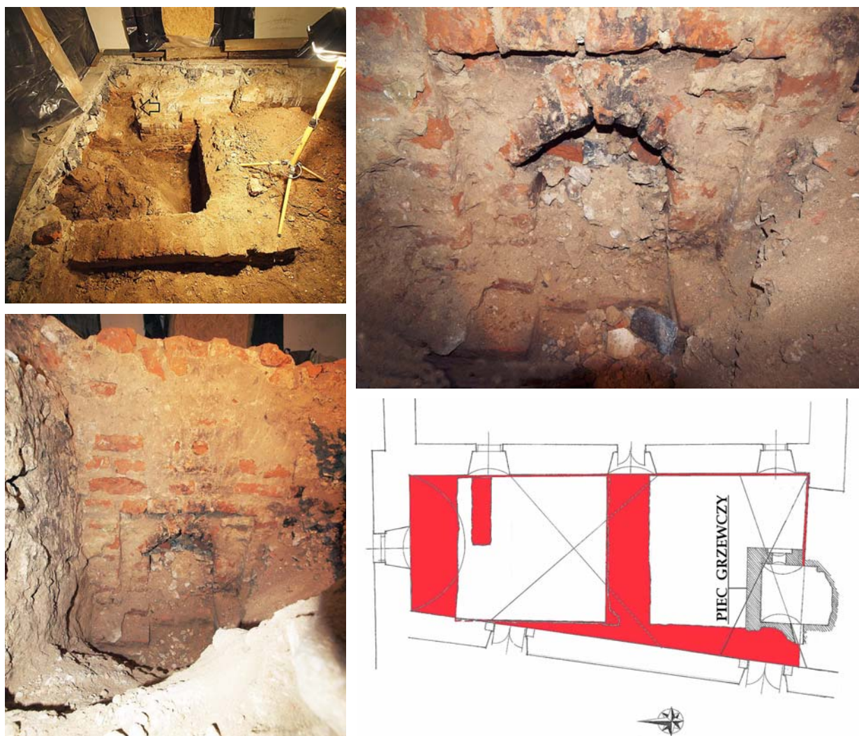
Ryc. 4. Imbramowice, klasztor norbertanek; obecny plan kaplicy z piecem odkrytym w narożniku (na czerwono oznaczono układ starszych murów średniowiecznych); odsłonięte korony murów pieca (strzałką oznaczono wlot do komina) oraz ściana czołowa z wlotem do dawnego paleniska, fot. A. Bojęś-Białasik
