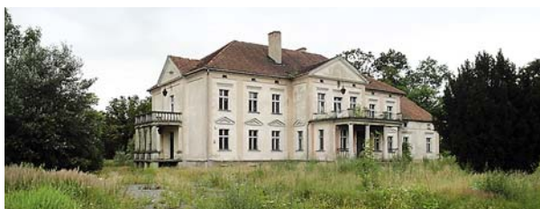
Ryc. 9. Obszerny dwór w Szlachcinie. Gruntowną przebudowę i rozbudowę siedziby przeprowadzono w roku 1899 według projektów Heliodora Matejki (fot. autor)
