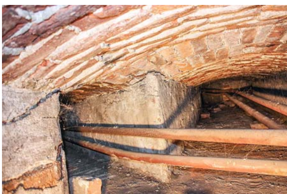
Ryc. 5. Klasztor karmelitanek bosych w Krakowie; widok wnętrza kanałów grzewczych pod kościołem oraz relikwii żeliwno-ceglanego pieca grzewczego, fot. A. Bojęś-Białasik
