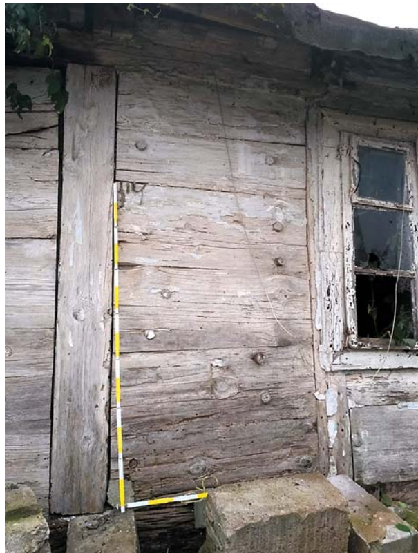
Ryc. 4. Czerwińsk nad Wisłą, dom przy ul. Kościuszki. Widoczne charakterystyczne kolki montażowe stosowane w szkutnictwie (fot. P.M. Pogodziński) Fig. 4. Czerwińsk on the Vistula, house n Kosciuszko Street. Characteristic mounting pegs used in boat building are visible. (photo P.M. Pogodziński)
