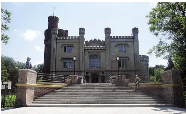
Ryc. 1. Zamek w Kórniku. Gruntowną przebudowę przeprowadzono w latach 1843–1861 (fot. autor)
