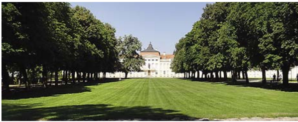
Ryc. 3. Pałac w Rogalinie. Restaurację rezydencji przeprowadzono na przełomie XIX i XX wieku (fot. autor)
