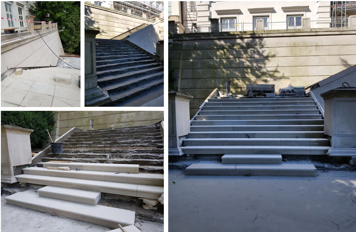
Ryc. 6, 7, 8, 9. Południowa część schodów głównych, łączących taras górny i dolny, w różnych fazach remontu, po rozbiórce uszkodzonych elementów i w czasie układania nowych stopni
