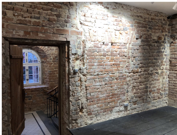
Ryc. 12. Zamek Górný, wieża bramna, poziom I piętra, ściana wewnętrzna z zablokowanym wejściem gotyckim i wylotem przewodu grzewczego, fot. A. Legendziewicz
