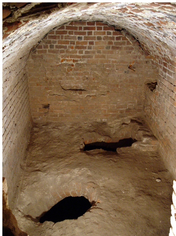
Ryc. 10. Opole, Zamek Górny, wieża bramna, poziom piwnic, pomieszczenie nad lochem, fot. A. Legendziewicz
