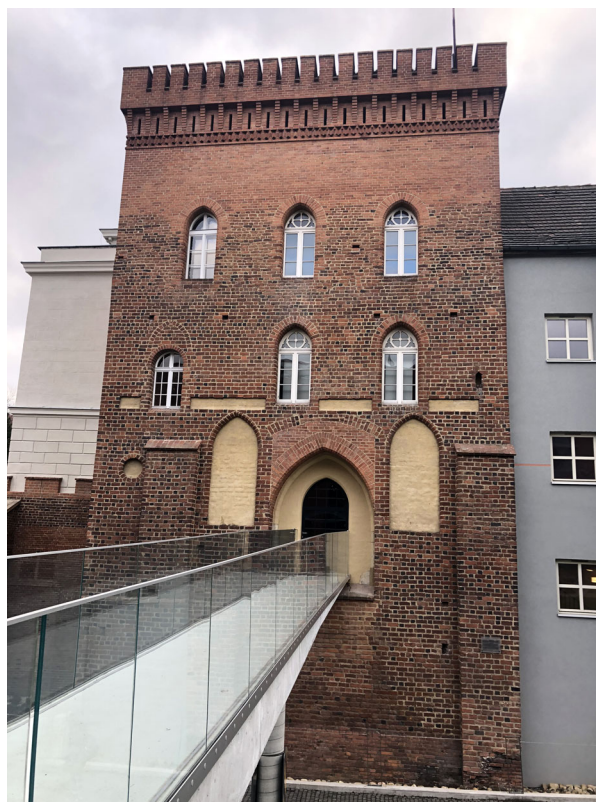
Ryc. 3. Opole, Zamek Górny, wieża bramna, elewacja wschodnia. (fot. A. Legendziewicz)
