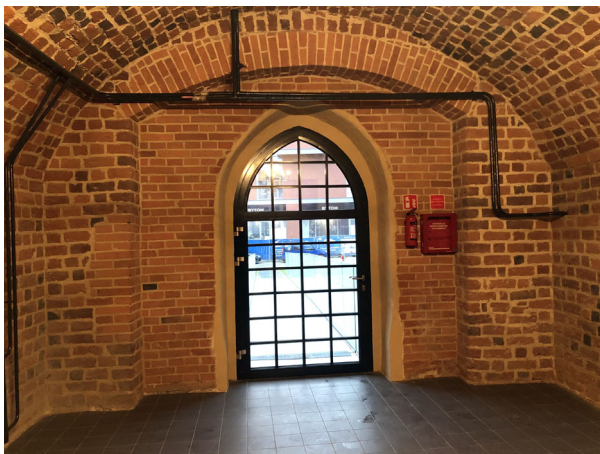
Ryc. 11. Zamek Górný, wieża bramna, poziom przejazdu, ściana wschodnia z otworem bramnym, fot. A. Legendziewicz
