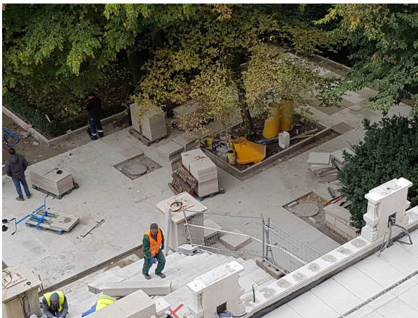
Ryc. 3, 4, 5. Widok z balkonu I pietra na taras górny (3), górny i dolny (4) i dolny (5). Widoczny jest montaż nowych balustrad
