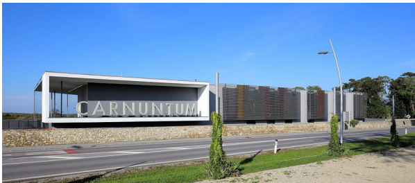
Ryc. 16. Park Archeologiczny w Carnuntum: nowoczesny budynek recepcyjny z 2009 roku
