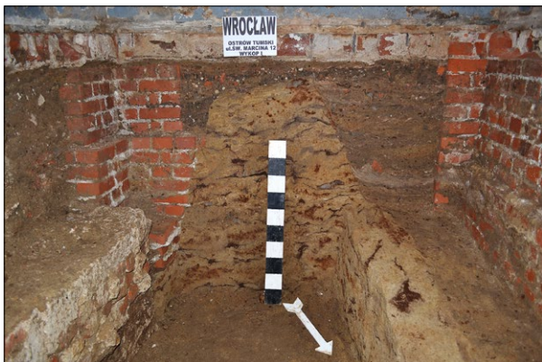
Ryc. 2. Wrocław, Ostrów Tumski, widok wału zniszczonego przez pierwszą fazę budowy zamku, rok 2011; fot. E. Wodejko.
