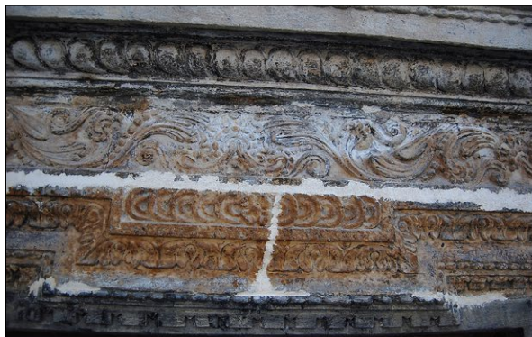
Fig. 4. Black House on Rynok Square in Lviv, filling in of cracks and crevices, 2018; photo by O. Rybchynskiy. Ryc. 4. Czarny Dom przy placu Rynkowym we Lwowie, uzupełnianie zarysowań i pęknięć, 2018; fot. O. Rybchynskiy.
