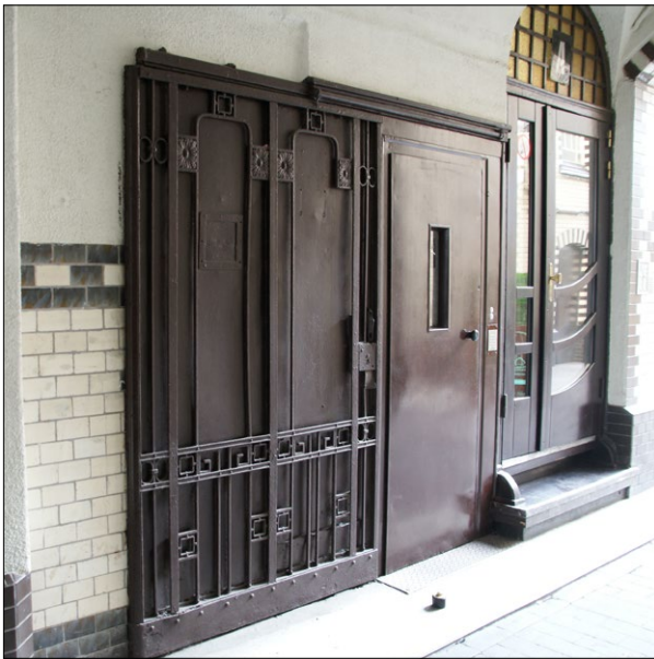
Ryc. 3. Poznań, kamienica mieszkalna, ul. Wielka 21, wejście w przejeździe bramnym z widocznymi oryginalnymi drzwiami szybowymi, stan na rok 2016; fot. K. Pietrzak.
